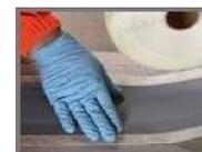
Mapeband TPE (Thermoplastique Polyoléfine Elastomère) est préconisé pour l'imperméabilisation des joints de dilatation d'ouvrages routiers, hydrauliques, de galeries et de toitures, sujets à des mouvements d'amplitudes inférieures à 5mm (Mapeband170) ou inférieures à 10 mm (Mapeband TPE 325). Il est mis en œuvre sur des supports propres et secs par collage avec des colles époxy bi-composant thixotropes ou mortier élastique à base de ciment bi-composant.
