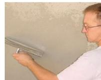
À mélanger avec du ciment pour la finition des bétons et enduits intérieurs et extérieurs. Épaisseur d'application: de 1 à 10 mm. Nivopâte G est facile à mélanger et à appliquer et ne présente pas d'odeur. Avant de l'appliquer s'assurer que le support est propre, sain, solide et exempt de poussière. Humidifier les supports à base de ciment. Ne pas rajouter d'eau au produit. En mélange avec du ciment, ne pas appliquer sur support plâtre. Nivopâte G s'applique à la lisseuse.
