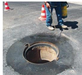
**MAPEGROUT SV GRAVIER: MICRO-BÉTON COULABLE DESTINÉ À LA RÉPARATION ET AU SCELLEMENT D'ÉLÉMENTS DE VOIRIE**
