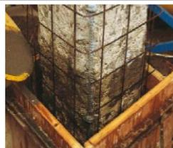
**MAPEGROUT SV FIBER: MORTIER DE RÉPARATION COULABLE À PRISE ET À DURCISSEMENT RAPIDES, À HAUTE DUCTIBILITÉ**
